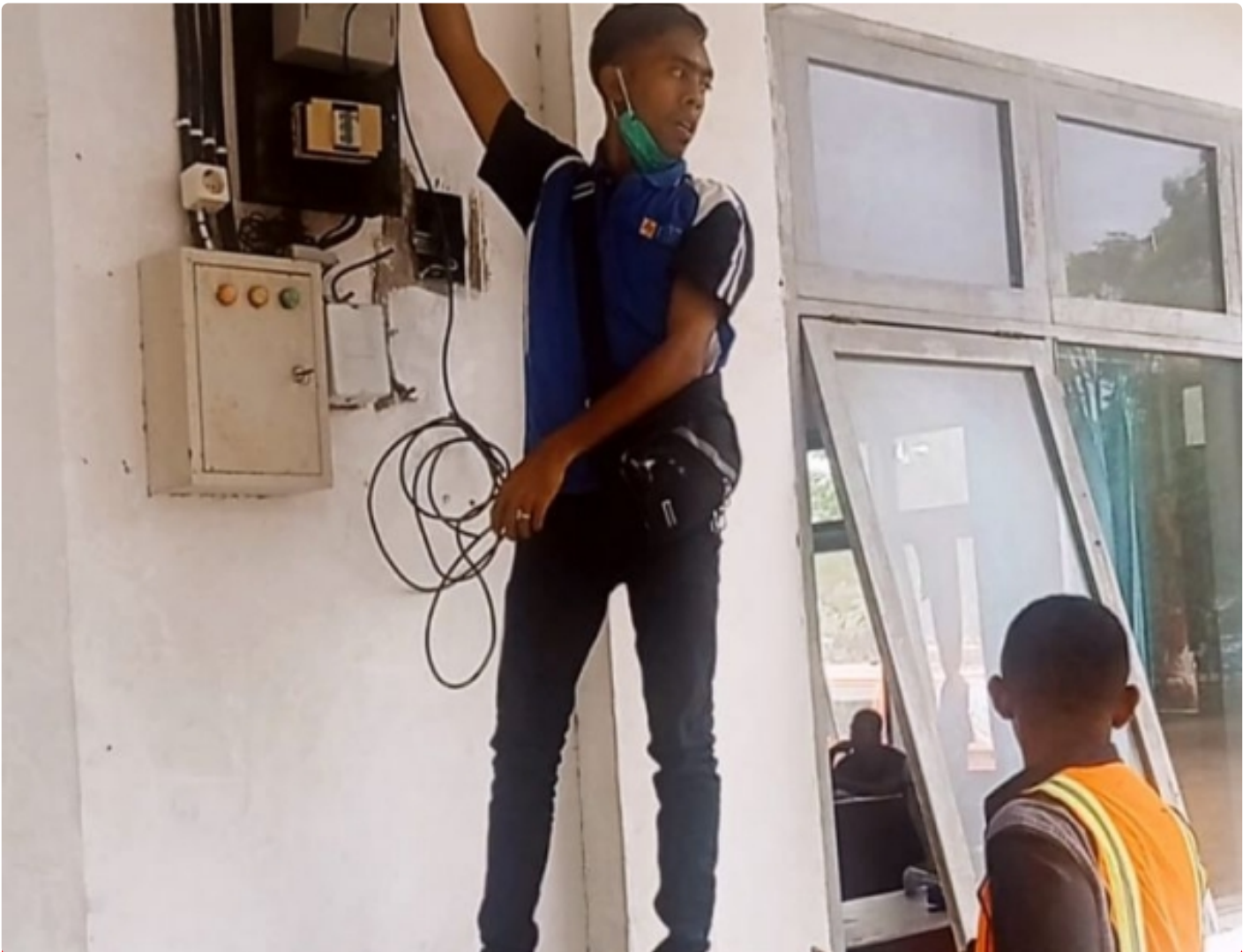
Pegawai PLN Ranting Bajawa tengah melakukan pengecekan arus
